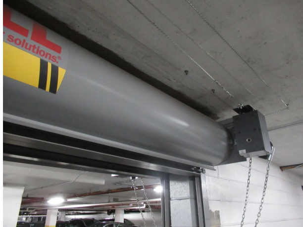
Garage fire door
