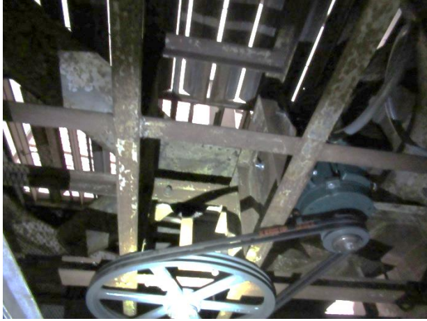
Garage exhaust fan
